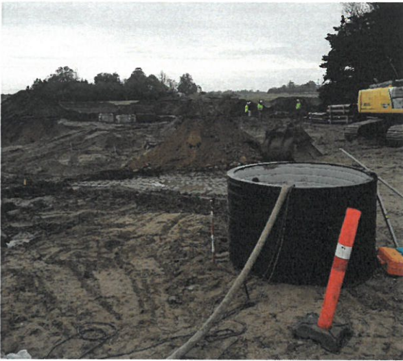
Pic. 2. Den nye pumpebrønd er sat. Bunden er 3 m under terræn.
