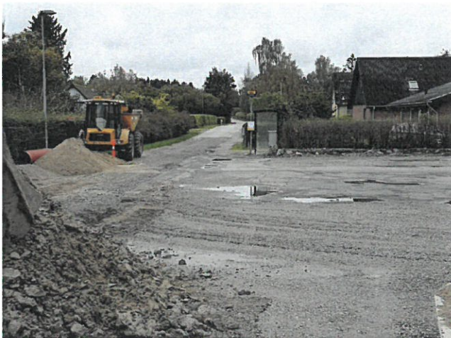
Pic. 6. Vi er snart færdige med 1. del. Så skal der fræses asfalt igen inden vi fortsætter med 2. del.
