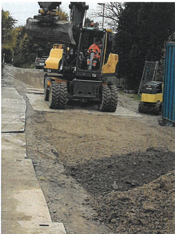
Pic. 5. Når ledningerne er lagt, fyldes graven op og der laves en ny vejkasse.
