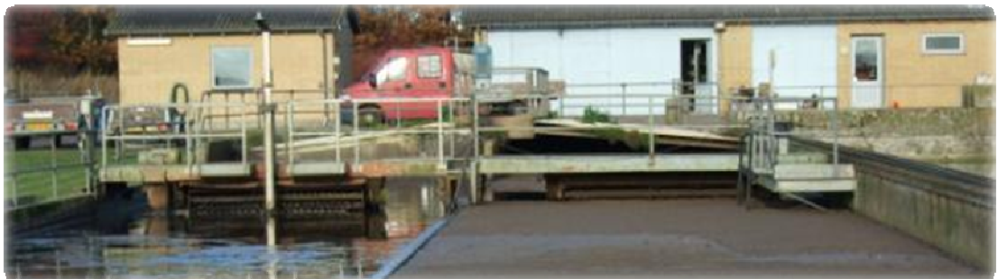
Luftningstanken på Dianalund Renseanlæg
